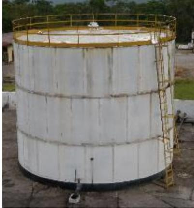
Figura 92. Vista lateral del tanque pernado
