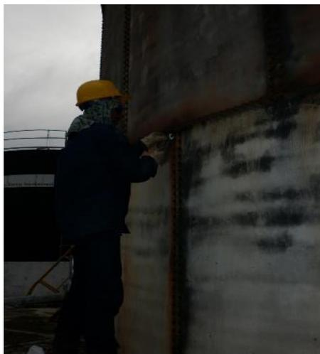
Figura 96. Tanque con lámina retirada
