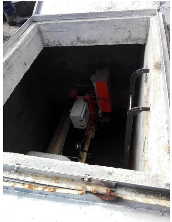
**Figura 87. Entrada búnker subterráneo transporte de gas**
