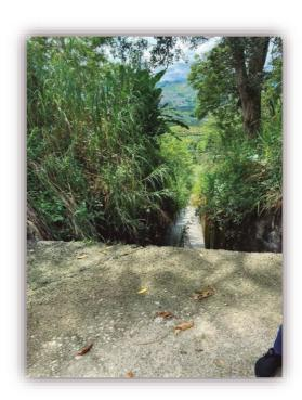
Medida de reducción: rebosadero para evitar inundación en el canal abierto
