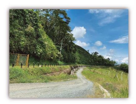
Obra con 7 cajas de instrumentación y 40 pernos de anclaje, también se elaboraron cunetas y drenajes en espina de pescado.
