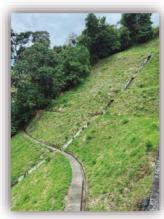
En las obras realizadas en planta ínsula se observa terraceo con zanjas recolectoras, pantalla activa con 54 pernos de anclaje y un canal central, se cuenta con un piezómetro para medir la altura del agua dentro del terreno y la presión de poros y así tener un mayor control de la obra.
