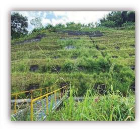
Obra con terraceo, pantallas pasivas en la parte superior, pernos de anclaje, canales laterales con columpios de tapa y 64 dados de anclaje, se encuentra en buen estado, no se observa socavación en las terrazas y no se visualizan fisuras.
