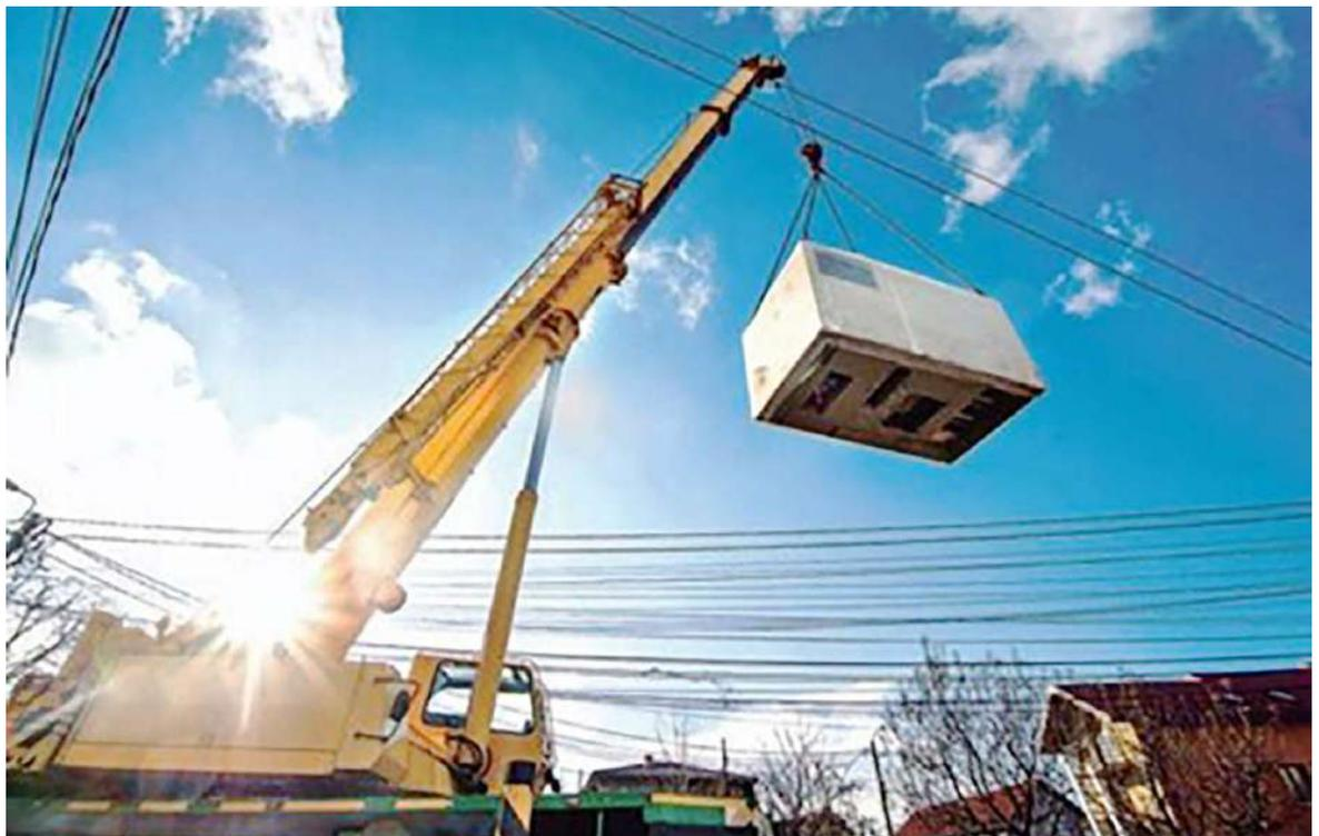
**Fotografía 10.** Izaje de carga con grúa móvil brazo telescópico, potencial cercanía a líneas energizadas. **Fuente:** Seguridad Minera, 2018.
