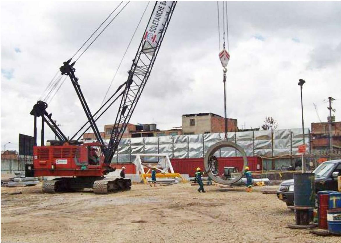
**Fotografía 12.** Izaje de carga con grúa de brazo celosía y montado en orugas. *Fuente: propia del autor.*
