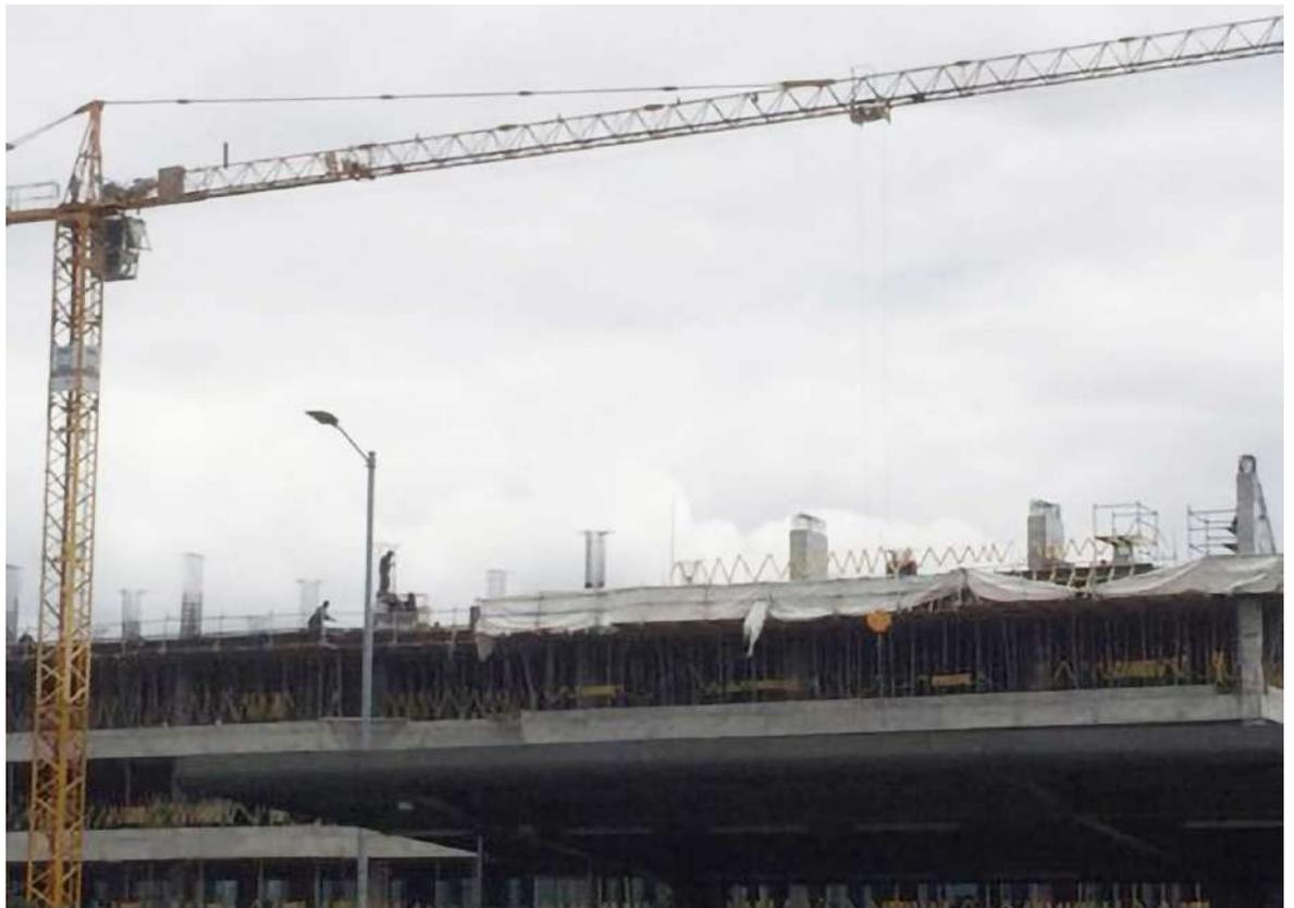
**Fotografía 14.** Trasiego de concreto con torre grúa. *Fuente: propia del autor.*
