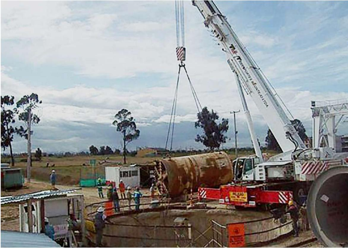
**Fotografía 11.** Izaje de tuneladora con grúa telescópica. *Fuente: propia del autor.*
