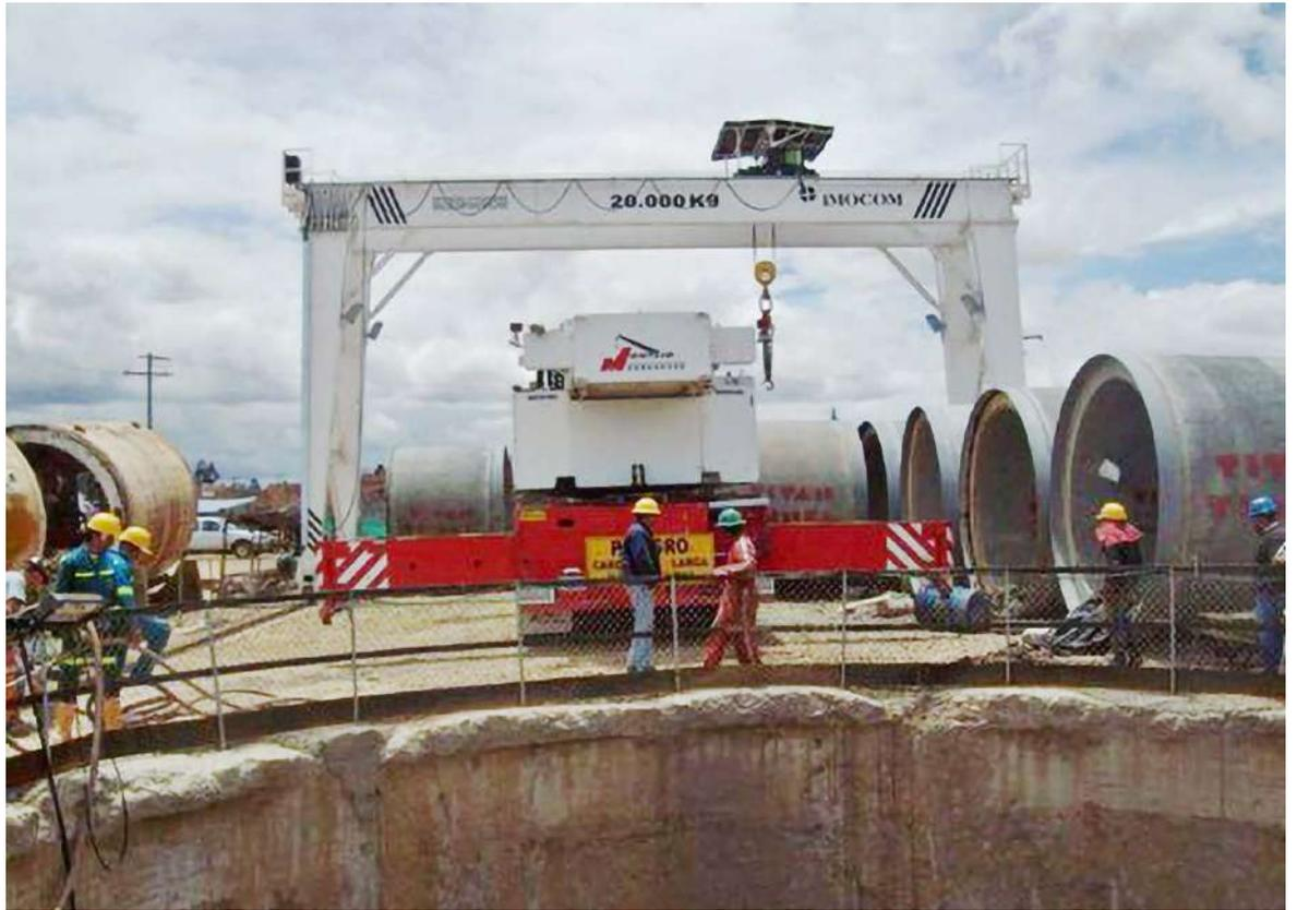
**Fotografía 13.** Izaje de tubería de concreto con puente grúa pórtico. *Fuente: propia del autor.*
