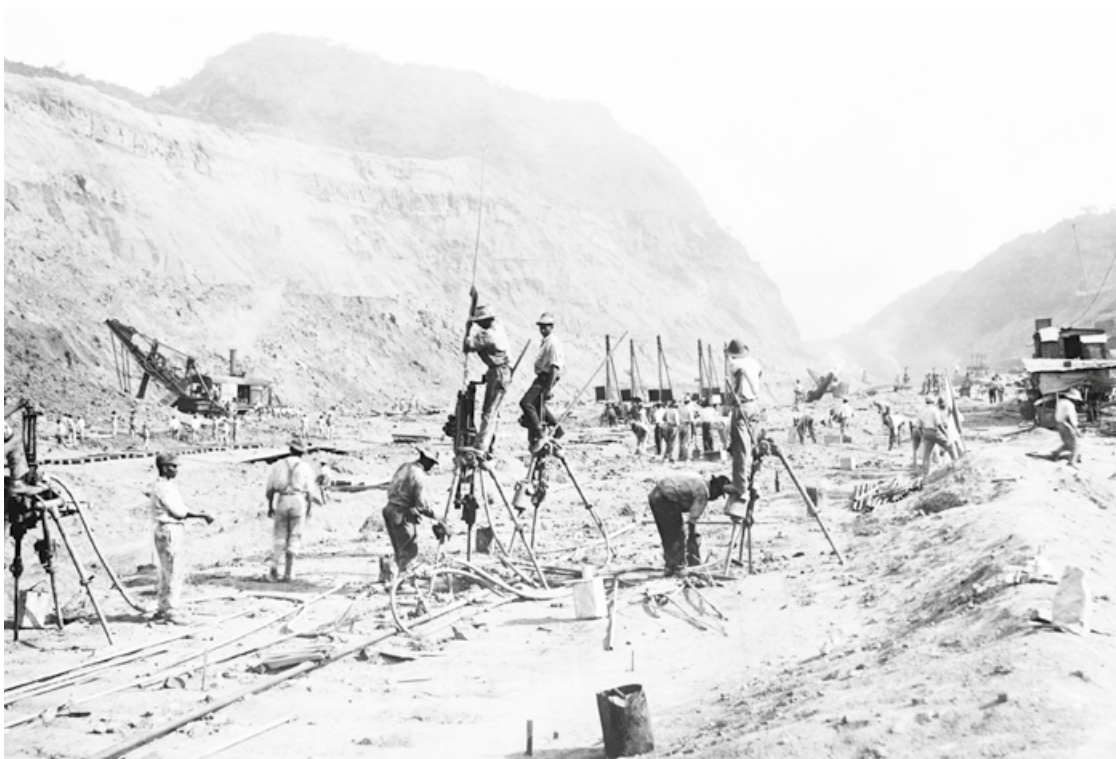
Imagen 17. Construcción del Canal de Panamá. Los trabajadores perforan hoyos de dinamita en rocas, mientras recortan montañas del Istmo. 1913. Fuente: Shutterstock.
