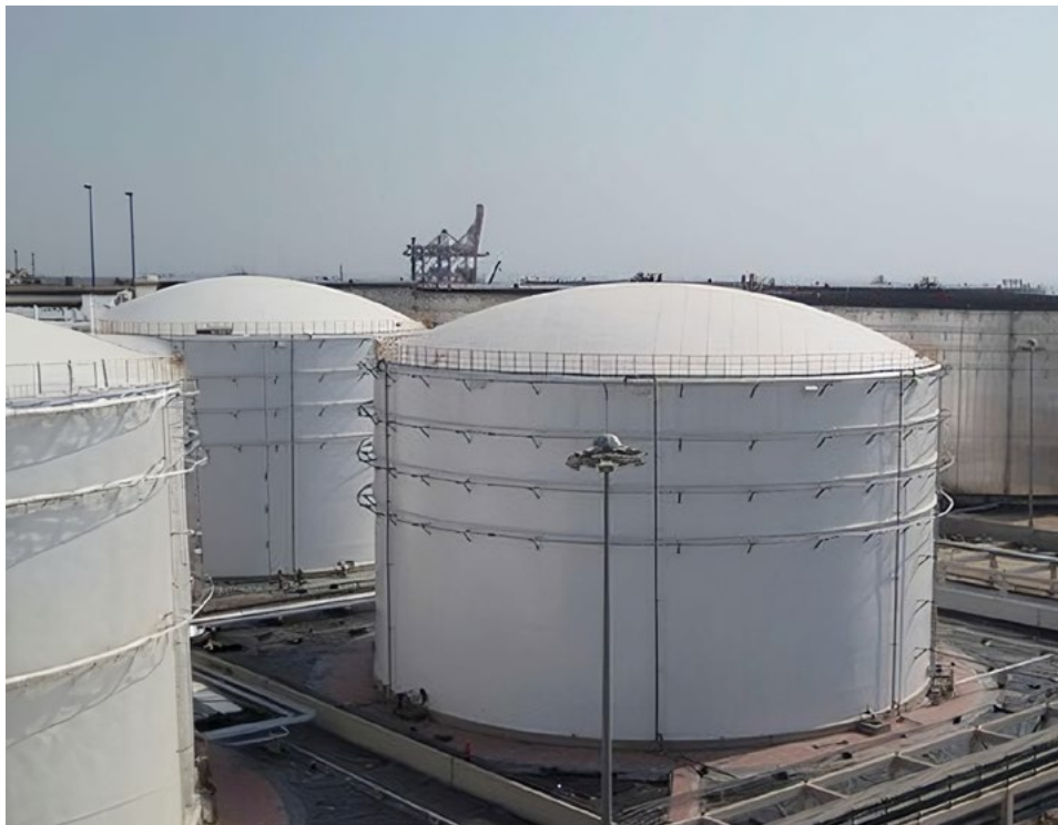
Figura 2. Tanque de techo fijo
