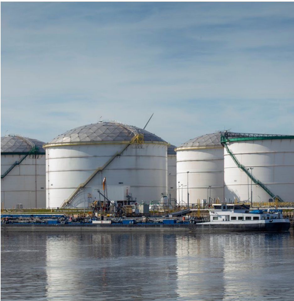
Figura 4. Tanque de techo flotante interno
