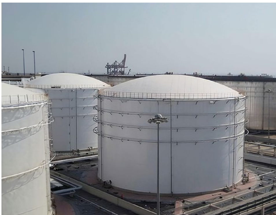
Figura 2. Tanque de techo fijo
