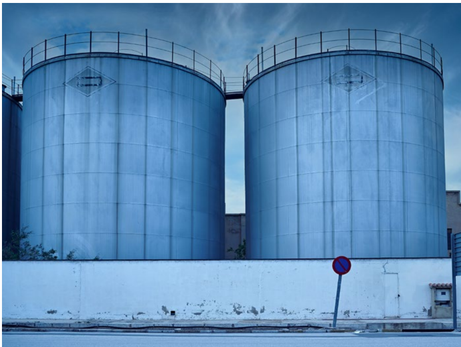
Figura 5. Tanque con corrosión
