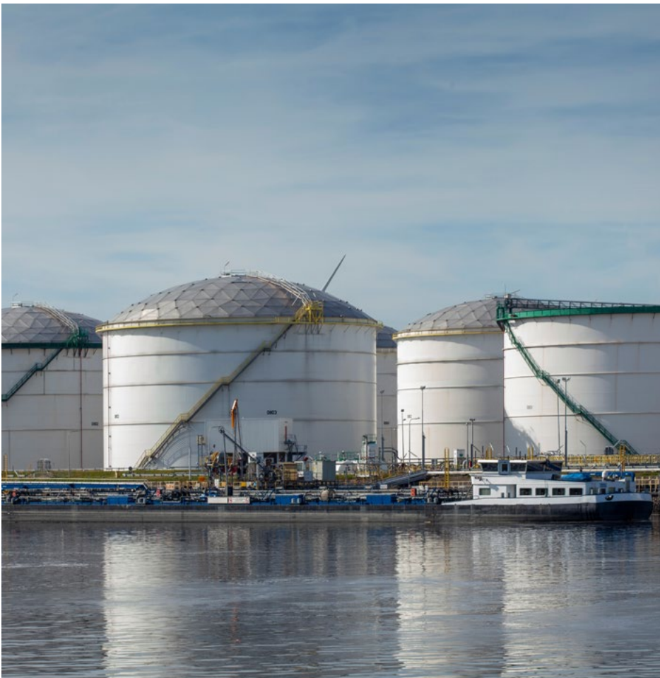
Figura 4. Tanque de techo flotante interno
