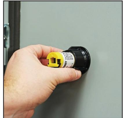
**3.** Ajuste la tuerca del panel hasta que tanto esta como la arandela de obturación hagan contacto completo con la superficie del gabinete. Luego, ajuste otro ¼ de vuelta. Ajuste la tuerca del panel solo con los dedos; no la apriete demasiado.
