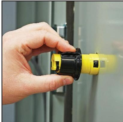
**2.** Coloque la tuerca del panel con la brida apuntando hacia la superficie interna del gabinete.
