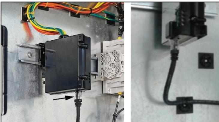
**6.** Inserte el otro extremo del cable de sistema del AVT en el conector que se encuentra en la parte inferior del módulo del indicador.
