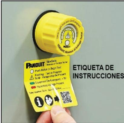
**9.** Coloque la etiqueta de instrucciones inmediatamente debajo o al lado del módulo del indicador, en la parte exterior de la caja (consulte la Nota 1). Marque la etiqueta para indicar en qué lugar del circuito está instalado el AVT.
