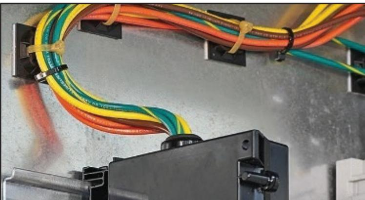
**8. Controle que el tendido de los cables del sensor y del cable de sistema del AVT evite los bordes filosos, puntos de apriete y daños mecánicos.**
