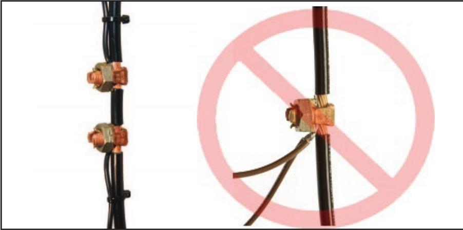
**7. Coloque terminales en los cables del sensor y de conexión a tierra. Fije los cables del sensor a los conductores y aisle las conexiones.**
