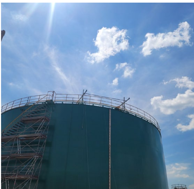
Figura 5. Planeación del montaje de andamios
