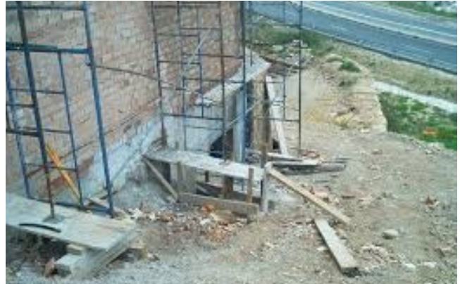
Figura 18. Andamio tipo modular de cruceta o “andamio para construcción”
