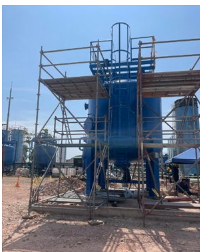
Figura 1. Uso de andamios en mantenimiento
