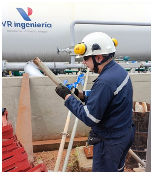
Figura 16. Inspección de andamios
