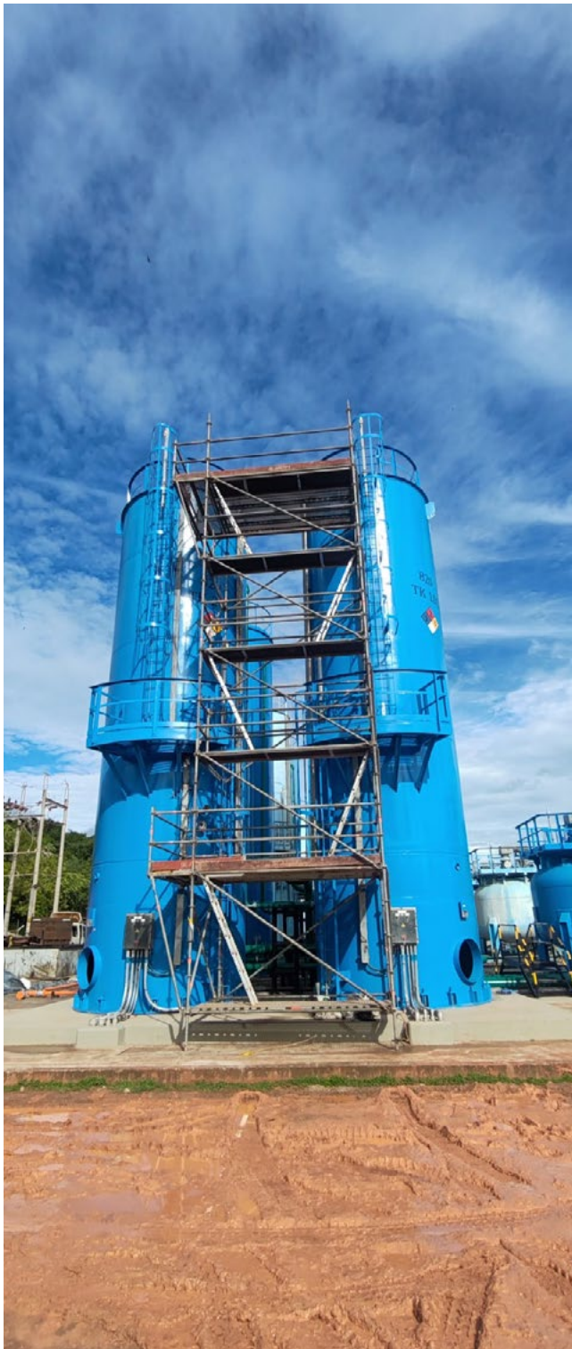
Figura 17. Uso de andamios en mantenimiento
