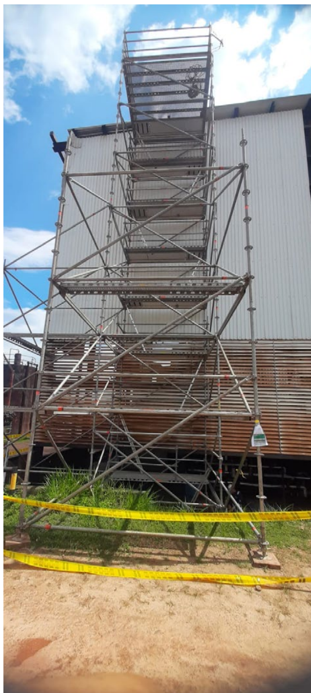
Figura 8. Uso de andamios en mantenimiento
