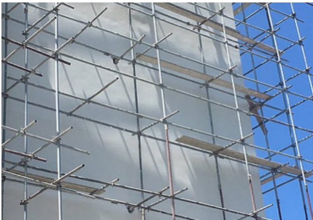
Figura 11. Andamio de tubería y acople
