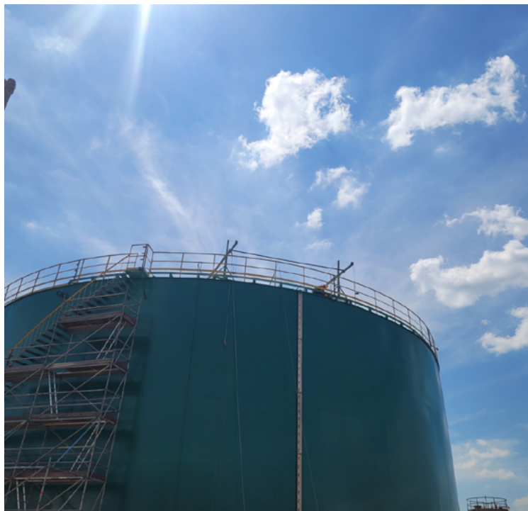
Figura 5. Planeación del montaje de andamios
