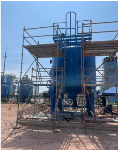
Figura 1. Uso de andamios en mantenimiento
