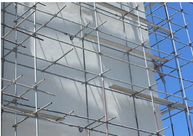
Figura 11. Andamio de tubería y acople
