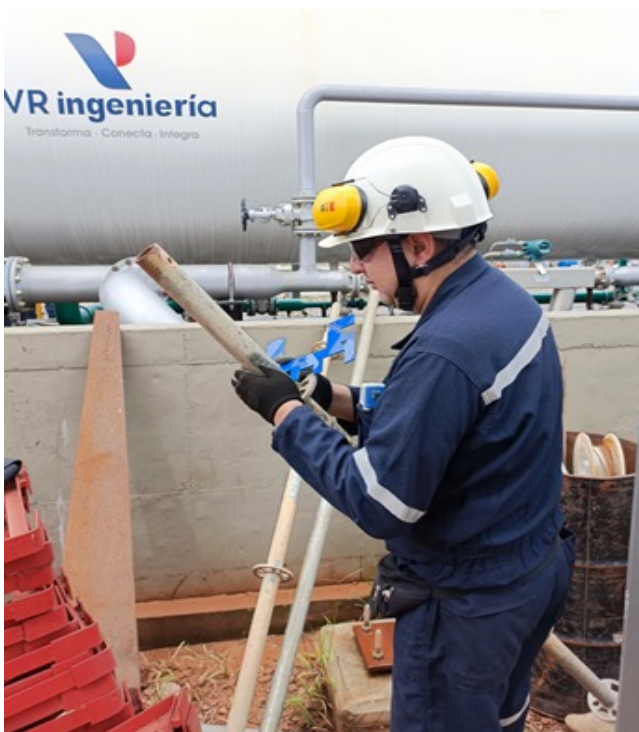
Figura 16. Inspección de andamios
