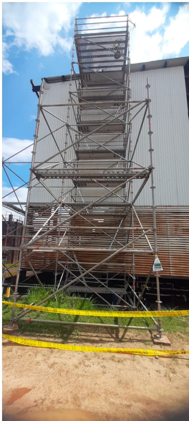
Figura 8. Uso de andamios en mantenimiento
