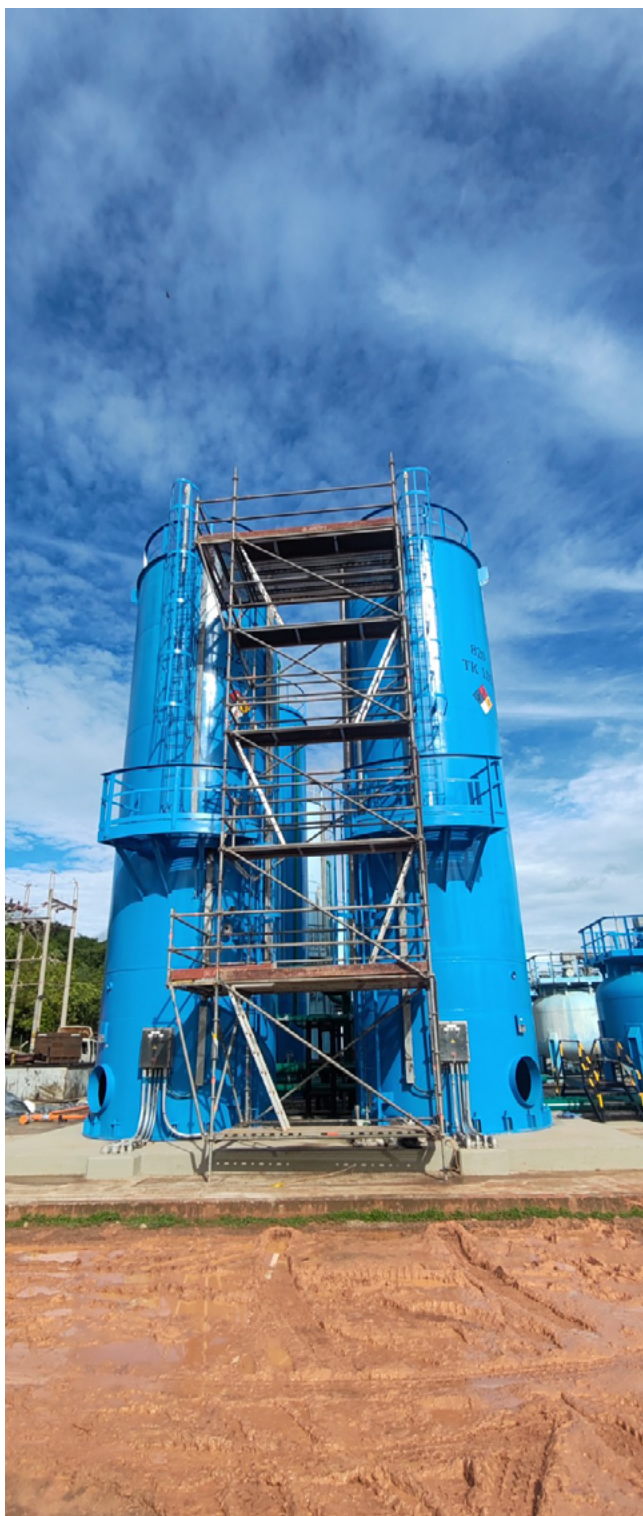
Figura 17. Uso de andamios en mantenimiento
